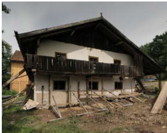
← 04 Das Bayerwaldhaus im Bauzustand: Die Außenwände der Stube werden abgestützt, da sie beim Betonieren des neuen Wohnraums als verlorene Schalung dienen.
